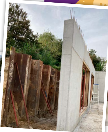
Betonwand en stalen damwand
