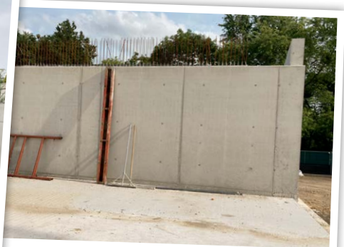
Betonwand onder het terras van de kantine
