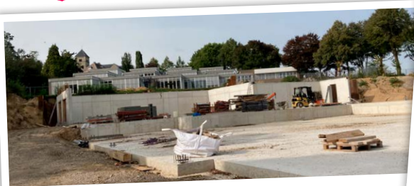
Overzicht onderste verdieping gebouw
